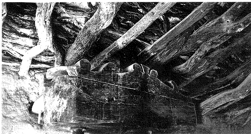
4-5. Μυλόπετρα και κτίσμα που στεγάζει το πιεστήριο (πάνω). Η δοκός του πιεστηρίου στον ελιόμυλο (δεξιά). Καρπασία. Αρχείο Β. Χατζημιχάλη.
